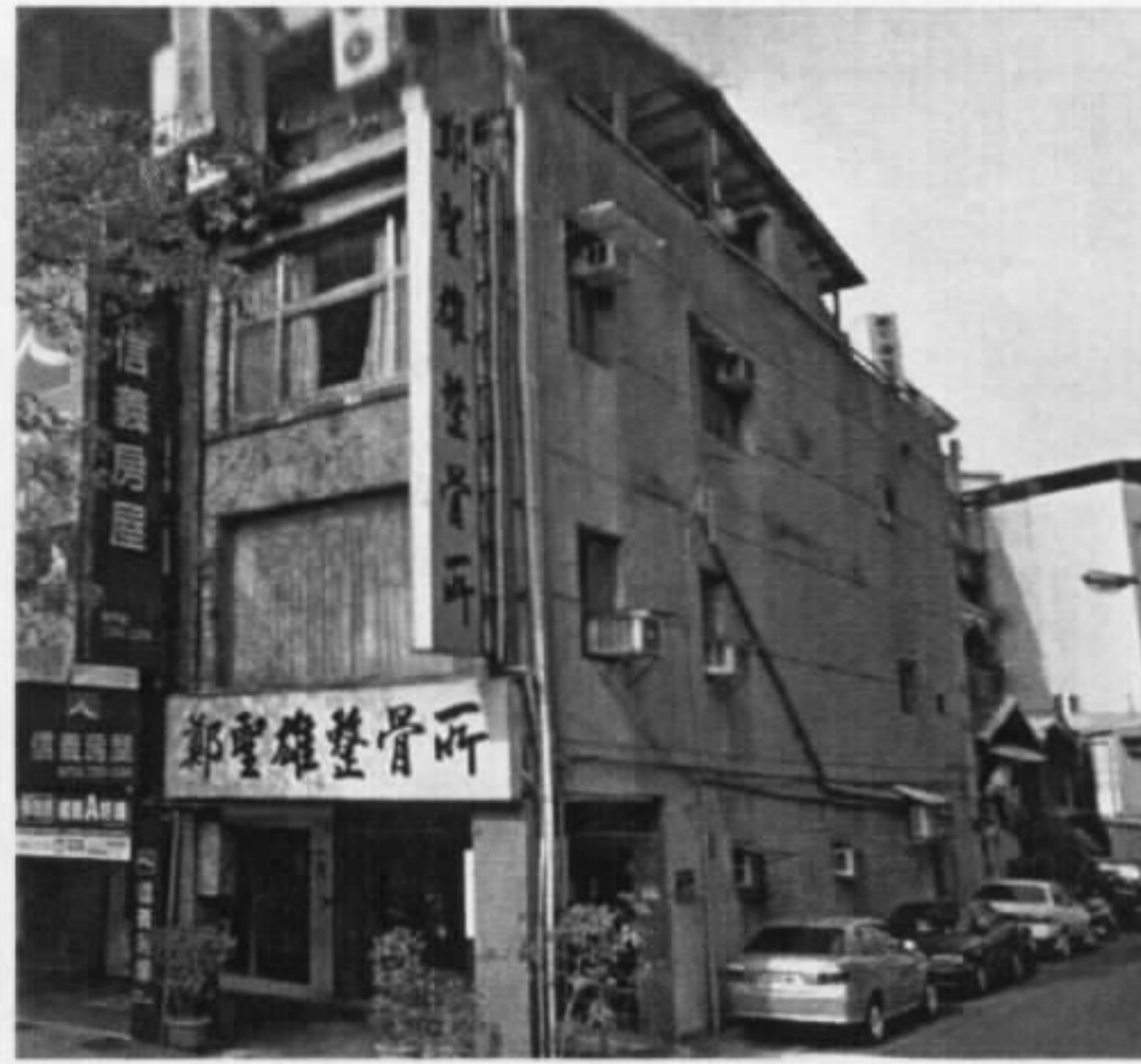
背（側）向立面照片
