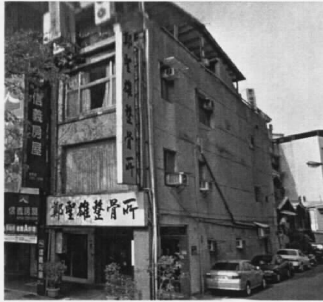
背(側)向立面照片
