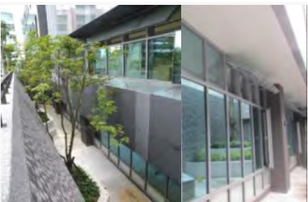
地下室採光天井
