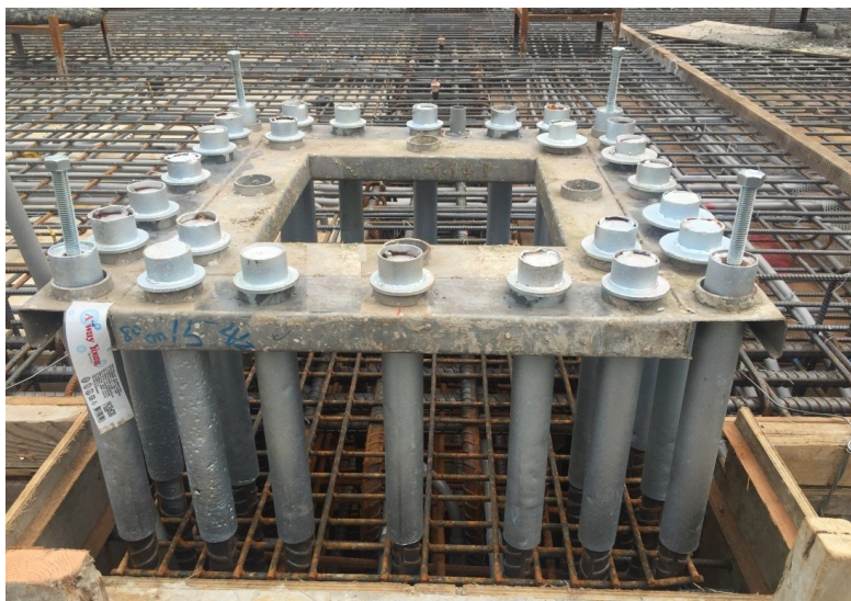
圖 R9.4 接合用鋼筋之定位板照片
